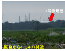
1号機建屋 原産から4.5キロ付近
